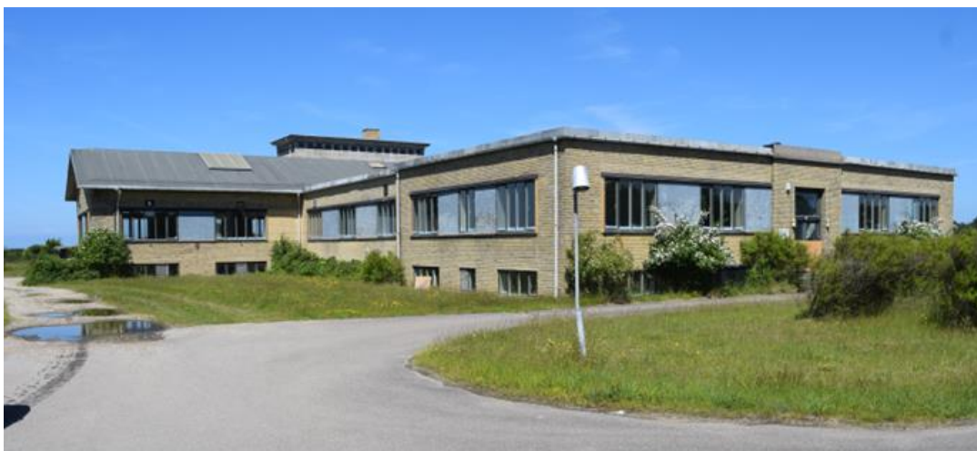
Den oprindelige hovedbygning med hovedindgangen, som p.t. er forsejlet for at undgå hærværk
